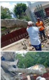
Trabajos de construcción en la calle 6 de Doctor Grullón.
