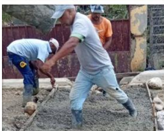
Trabajos de construcción en la calle 6 de Doctor Grullón.
